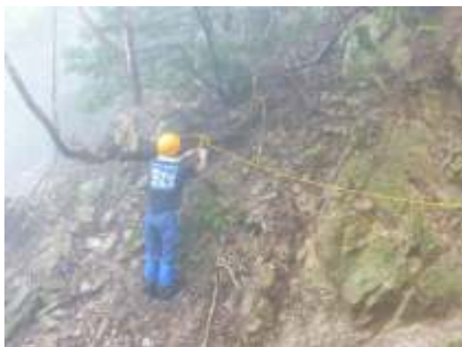
②青ガレ手前ロープ設置
