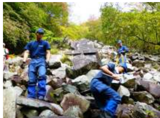
⑥青ガレ道標設置後
