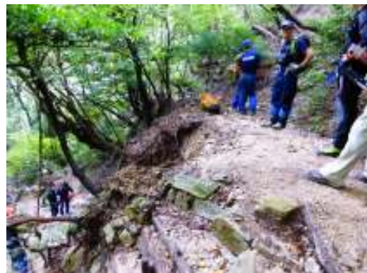
⑰ダケ道ロープ設置(カモシカ台下手)
