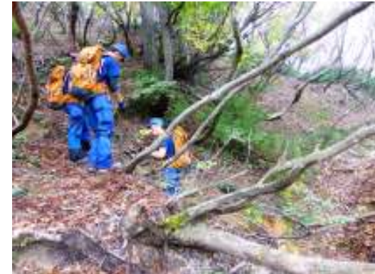
⑮ダケ道ロープ設置(急坂下手)
